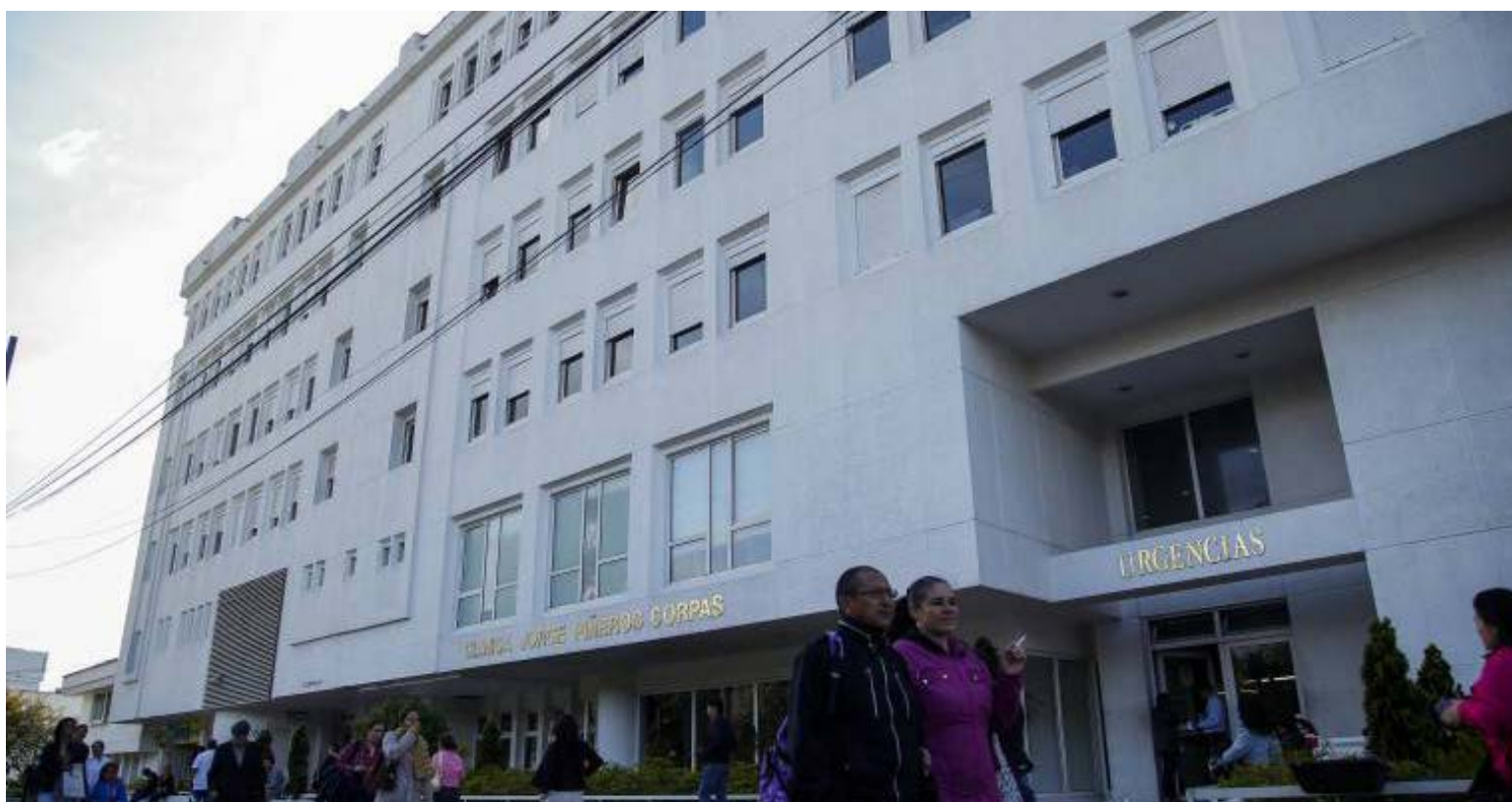
Faltan implementos básicos como guantes de manejo y toallas de papel. Se evidencia que no se ha realizado mantenimiento a los equipos médicos especializados, como los de la sala de cirugía cardiovascular.
