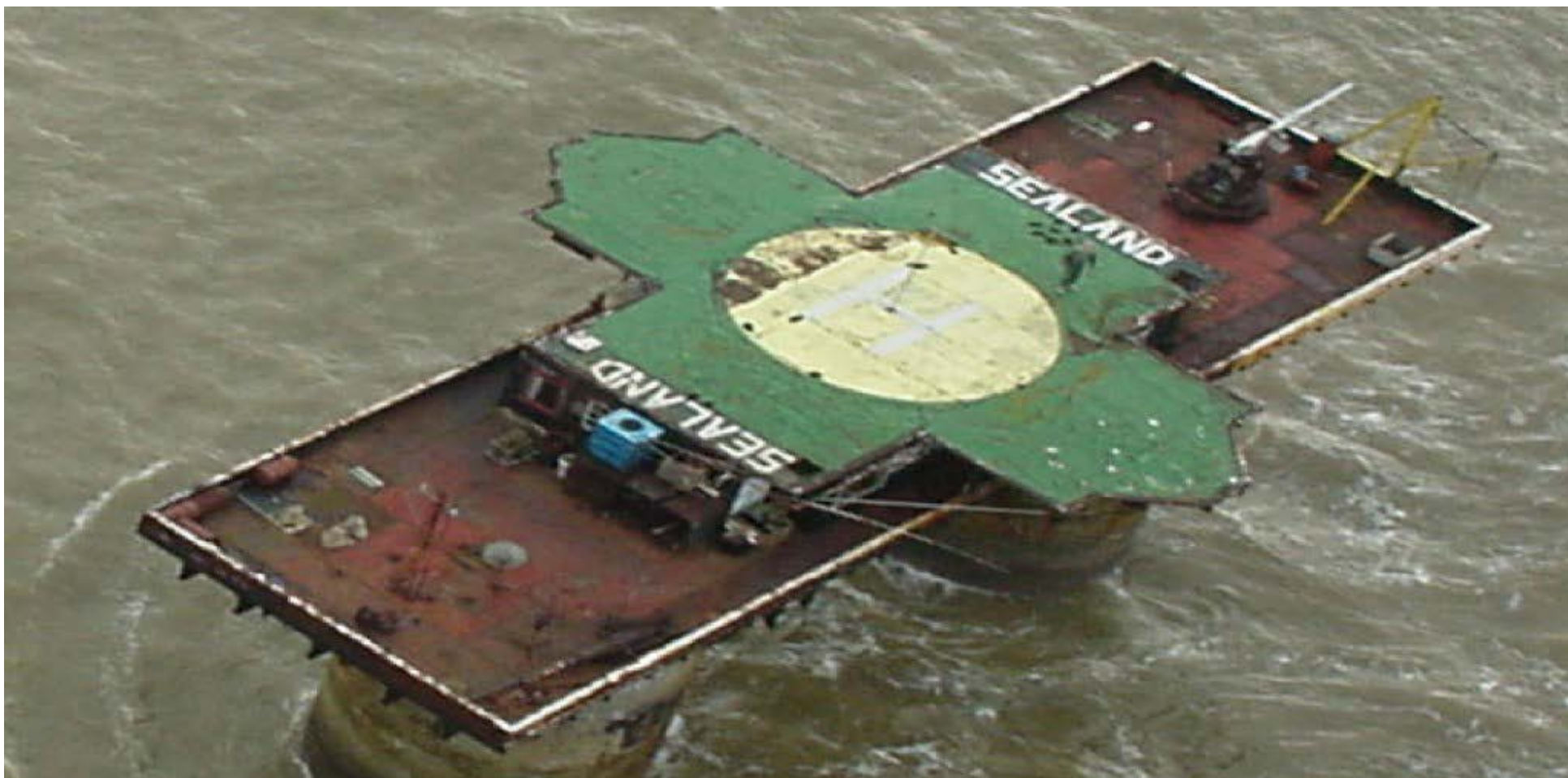
El arquitecto civil Guy Anson Maunsell encontró la solución. Pensó en defender el estuario construyendo fuertes en medio del mar, la idea que inicialmente fue rechazada se consolidó como la alternativa más viable y de este modo se establecieron siete fuertes: Knock John, Tongue Sands, Sunk Head, Roughs Tower Shivering Sands, Red Sand y Great Nore.
