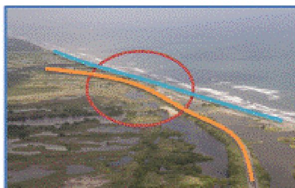
★ 2009: Posterior a la construcción de la carretera se presenta en el km 19 pérdida de las playas, dunas y lagunas debido a la erosión.
