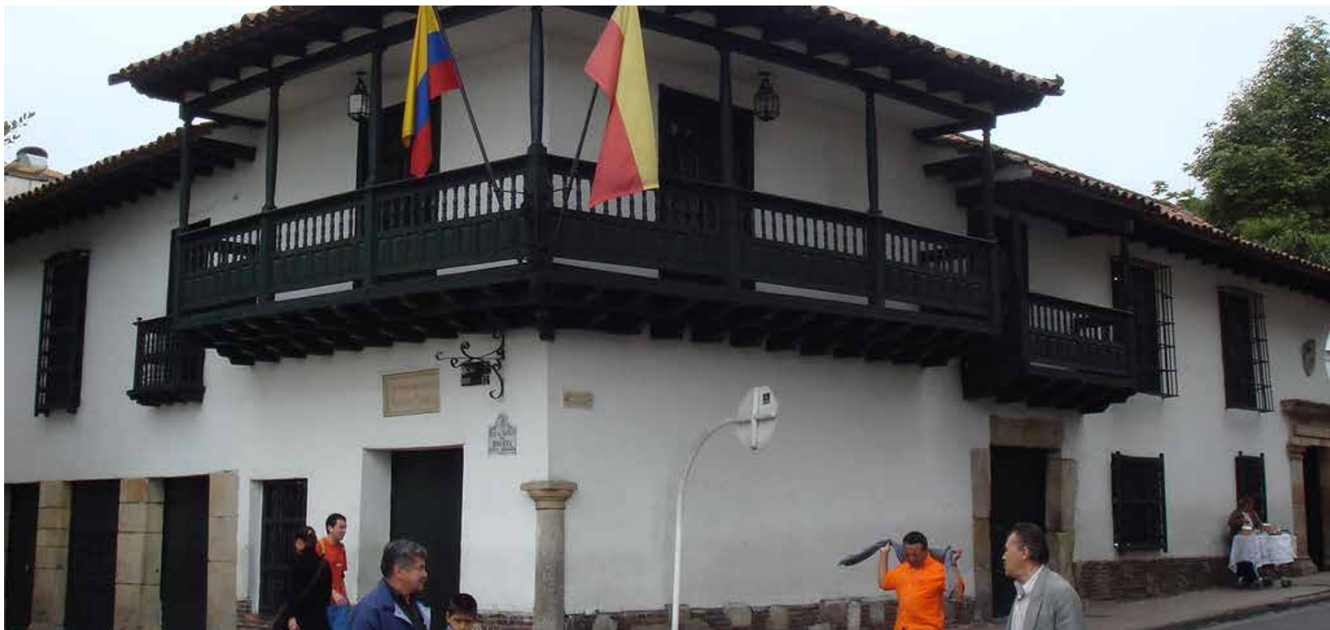
La casa, localizada en la carrera séptima con calle 11, frente a la catedral Primada de Bogotá y diagonal a la Plaza de Bolívar, se ha mantenido casi que intacta.
