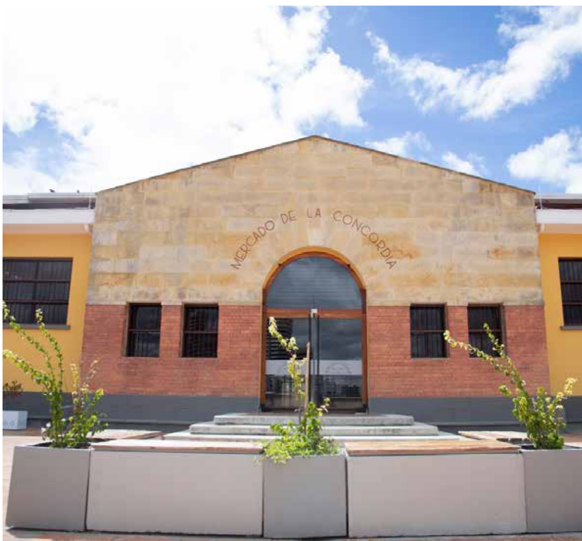
La Plaza de Mercado La Concordia, remodelada y entregada al servicio de la comunidad.
