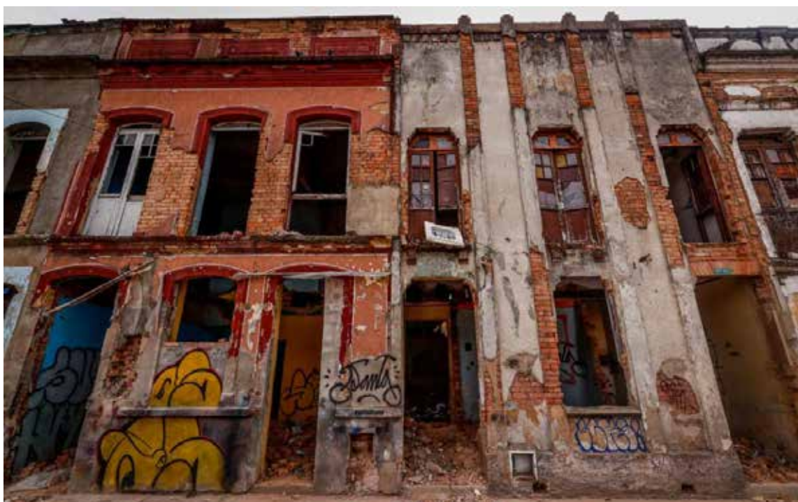
Las viejas edificaciones que empezaron a ser demolidas.
