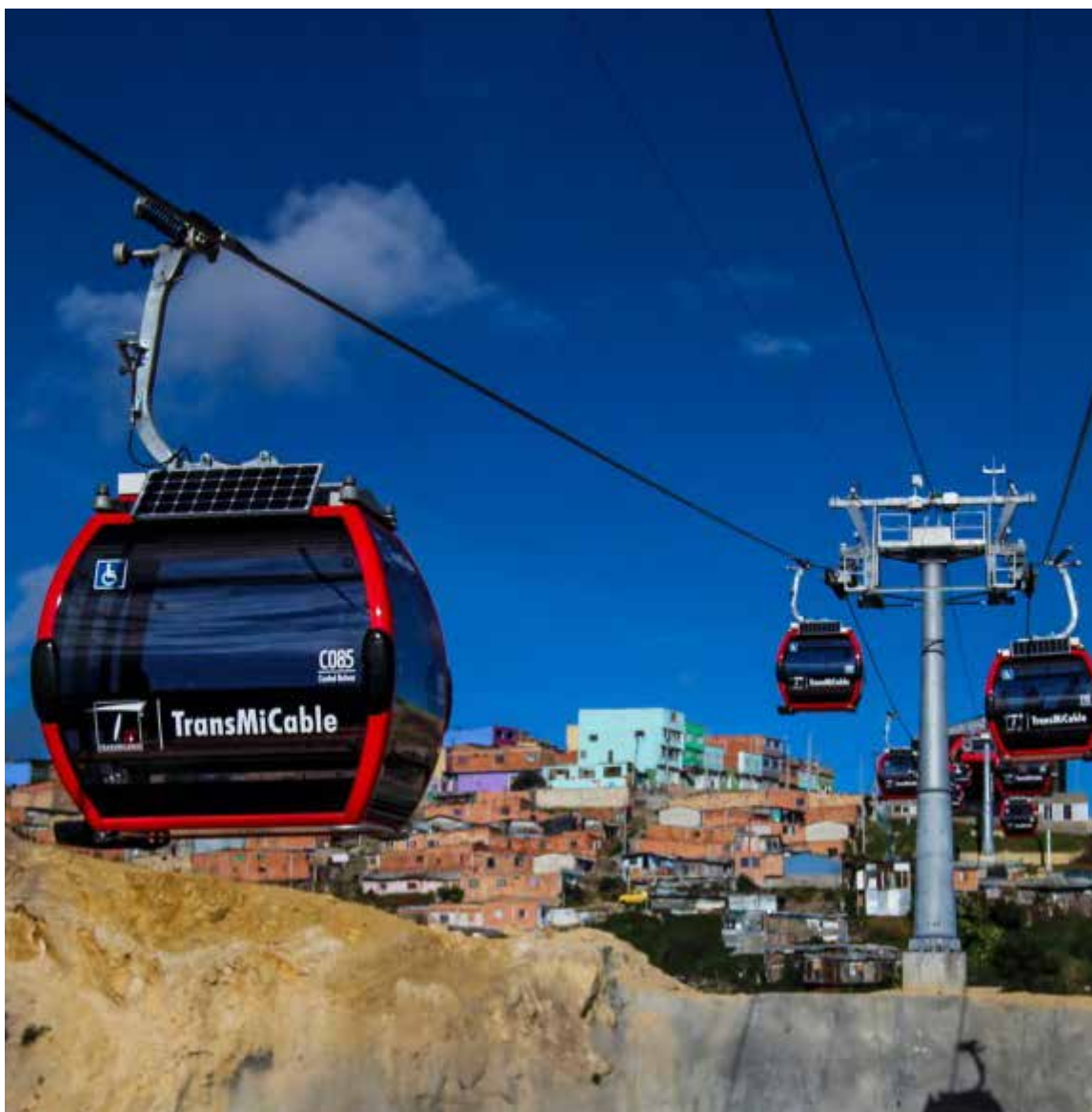
Con la construcción del mirador Illimaní, en la cima del TransMiCable, Bogotá contará con un importante sitio de turismo donde los visitantes nacionales e internacionales conocerán Ciudad Bolívar.
