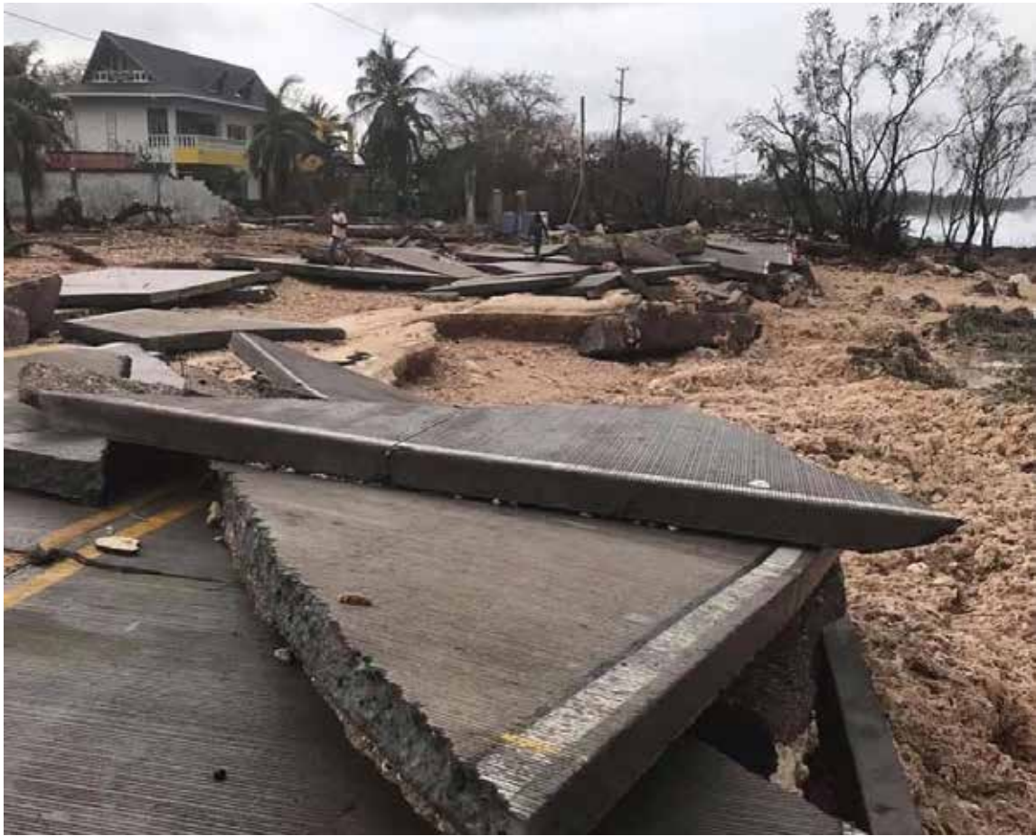
Así quedó la avenida circunvalar de San Andrés
