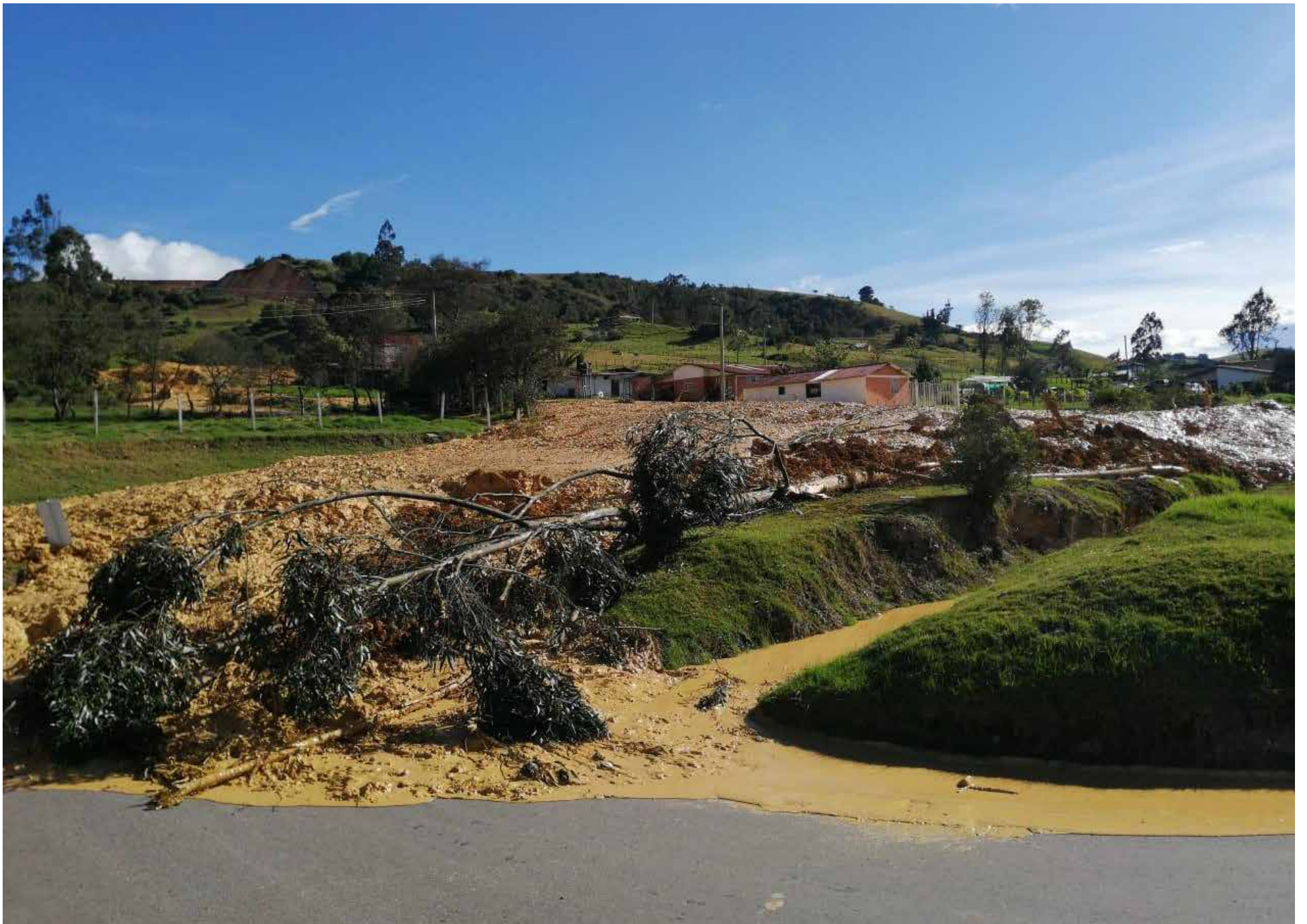
Aspecto de la inundación de la carretera con lodo, agua y árboles
