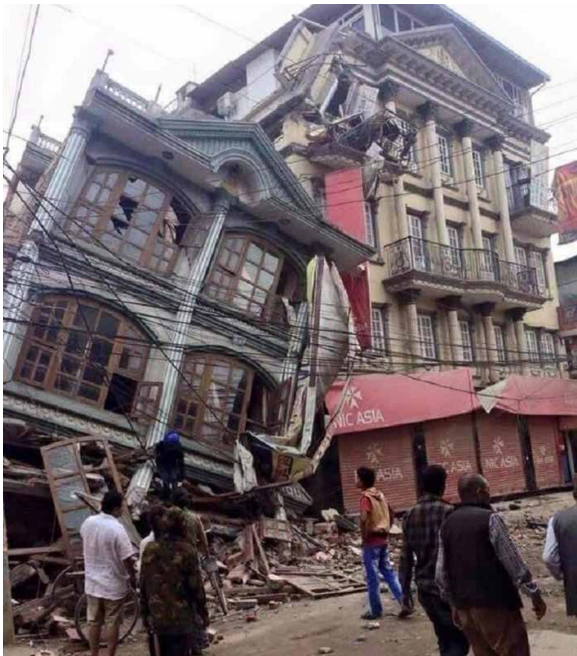
Un huracán causó que los edificios se inclinen uno sobre el otro. Katmandú, Nepal.
