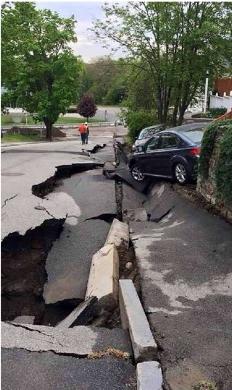
Esta calle se hundió luego del terremoto ocurrido en Worcester, Massachusetts.
