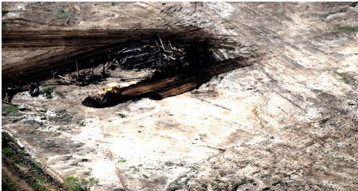
Las obras identificadas están afectando el humedal Ramsar – Reserva de Biosfera delta del río Magdalena Ciénaga Grande de Santa Marta, en general, así como al Área Protegida del Sistema de Parques Nacionales Naturales de Colombia
