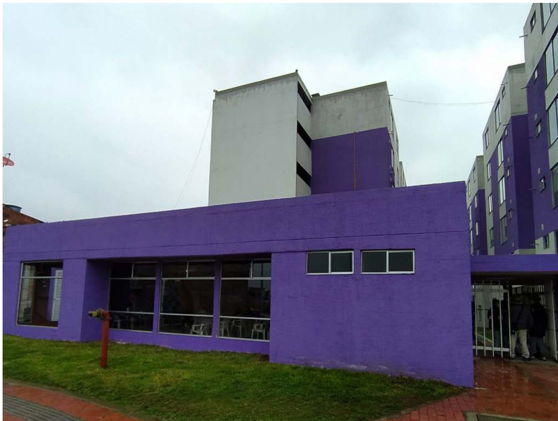
Modernos apartamentos fueron entregados a las personas que habitan en zonas de riesgo en Bogotá.
