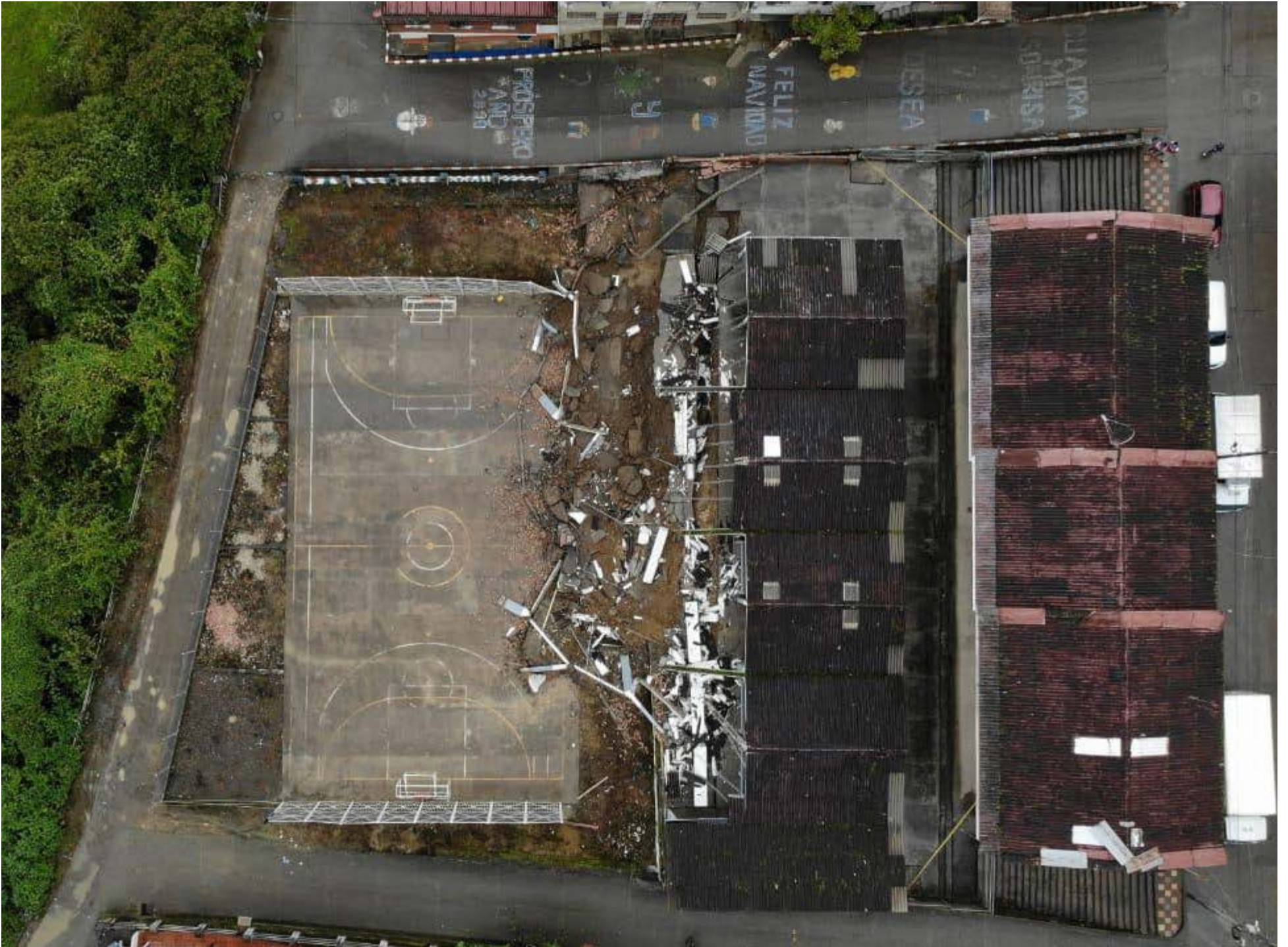
Desde el aire se aprecia los daños que registró la caída de un muro que afectó la Plaza de Mercado y el centro deportivo de Ubalá.
