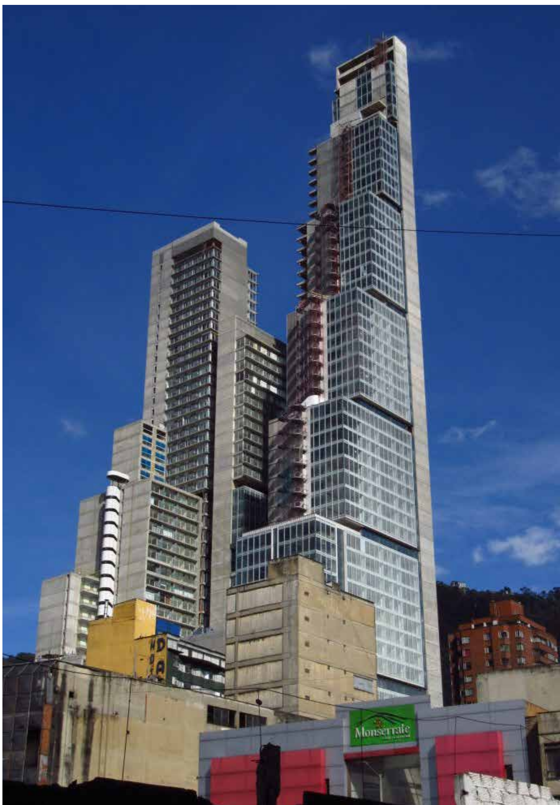
Los pisos de arriba se encuentran en obra negra. El dinero no alcanzó para la construcción de las escaleras de emergencia.
