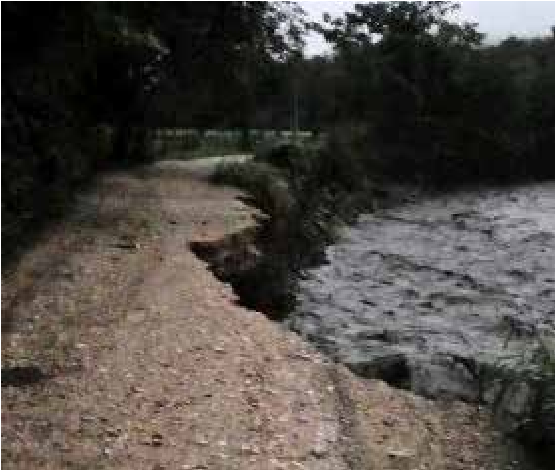
Las bancas de ls carreteras destruidas por el crecimiento de los ríos.
