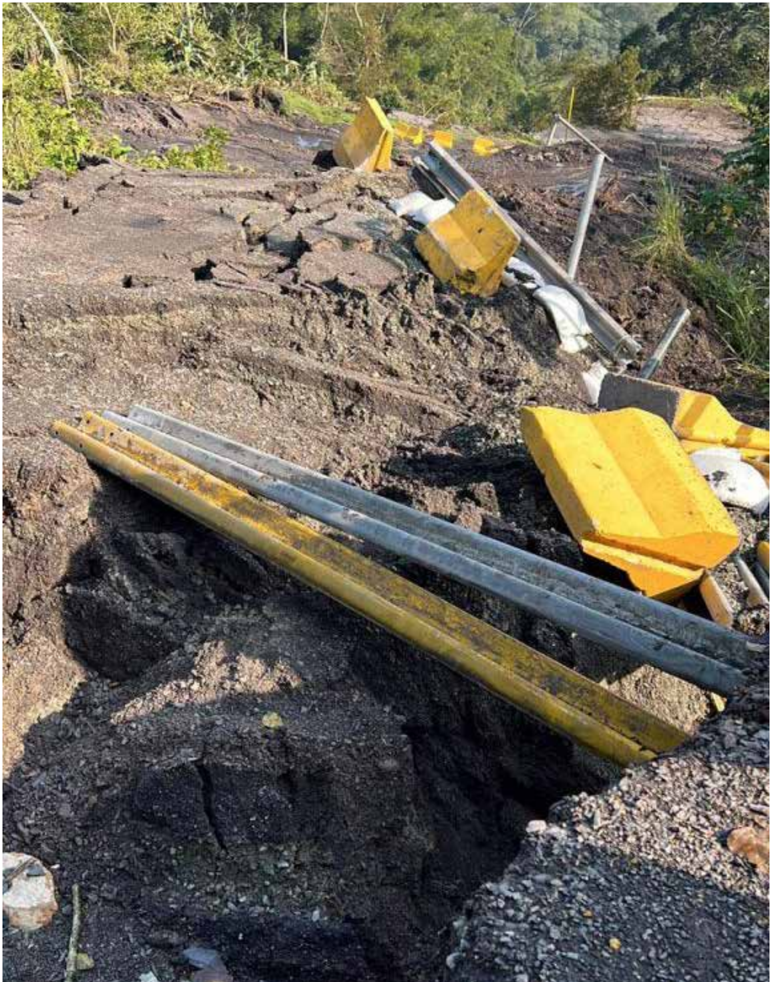
Estado actual de la vía
