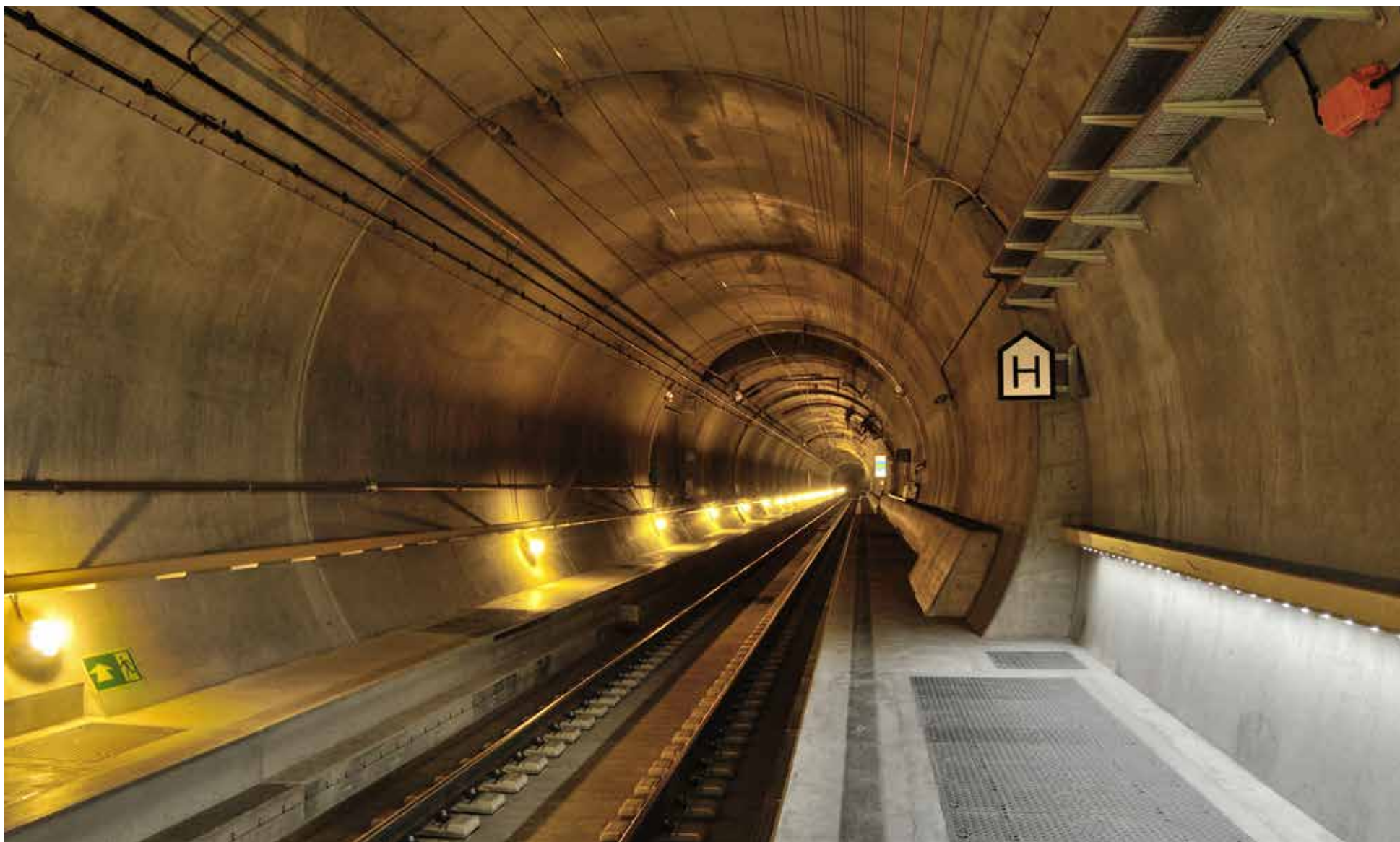
El túnel ferroviario bajo los Ales en Suiza que atraviesa el Macizo de San Gotardo en los Alpes Lepontinos. Con una longitud de 57,09 km y un total de 151,84 km de túneles y galerías, es el túnel ferroviario más largo y profundo del mundo.
