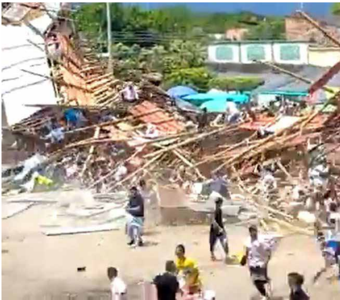
El palco que colapsó por exceso de ocupación
