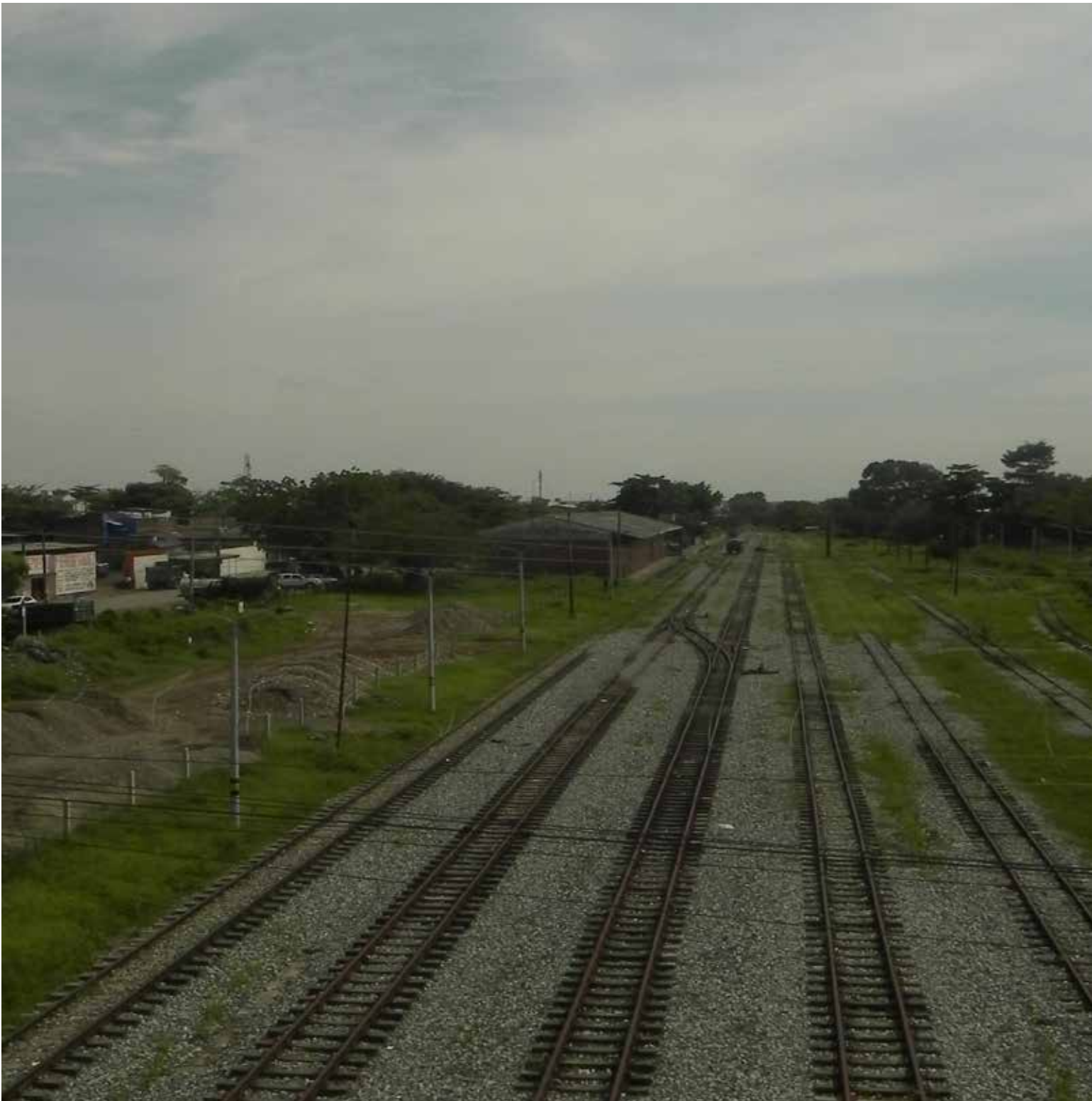
En total abandono las vías del ferrocarril en Barrancabermeja, Santander.
