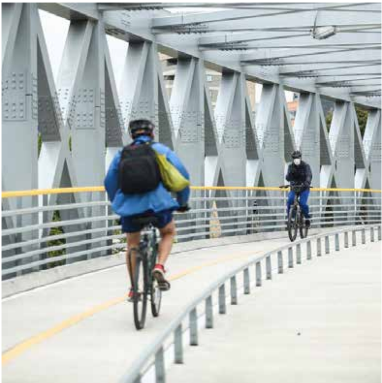
Con los aportes de valorización que hicieron los habitantes de Suba y Usaquén se puso al servicio de la ciudadanía el ciclo puente Canal Molinos, una obra que permitirá mejorar la movilidad de los ciclistas y peatones que transitan por este sector de la ciudad.
