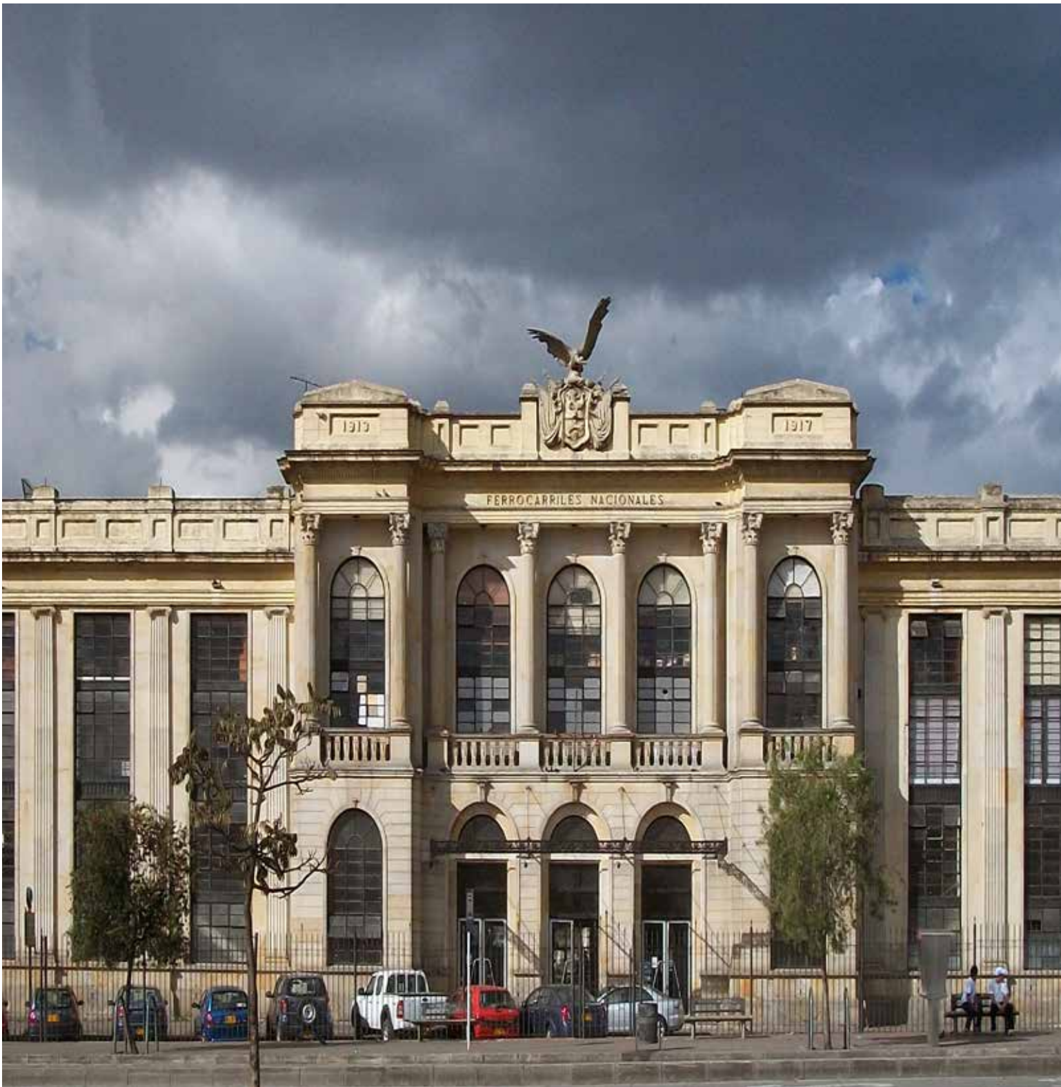
Estación de La Sabana en Bogotá fue una de las primeras construidas en Colombia.
