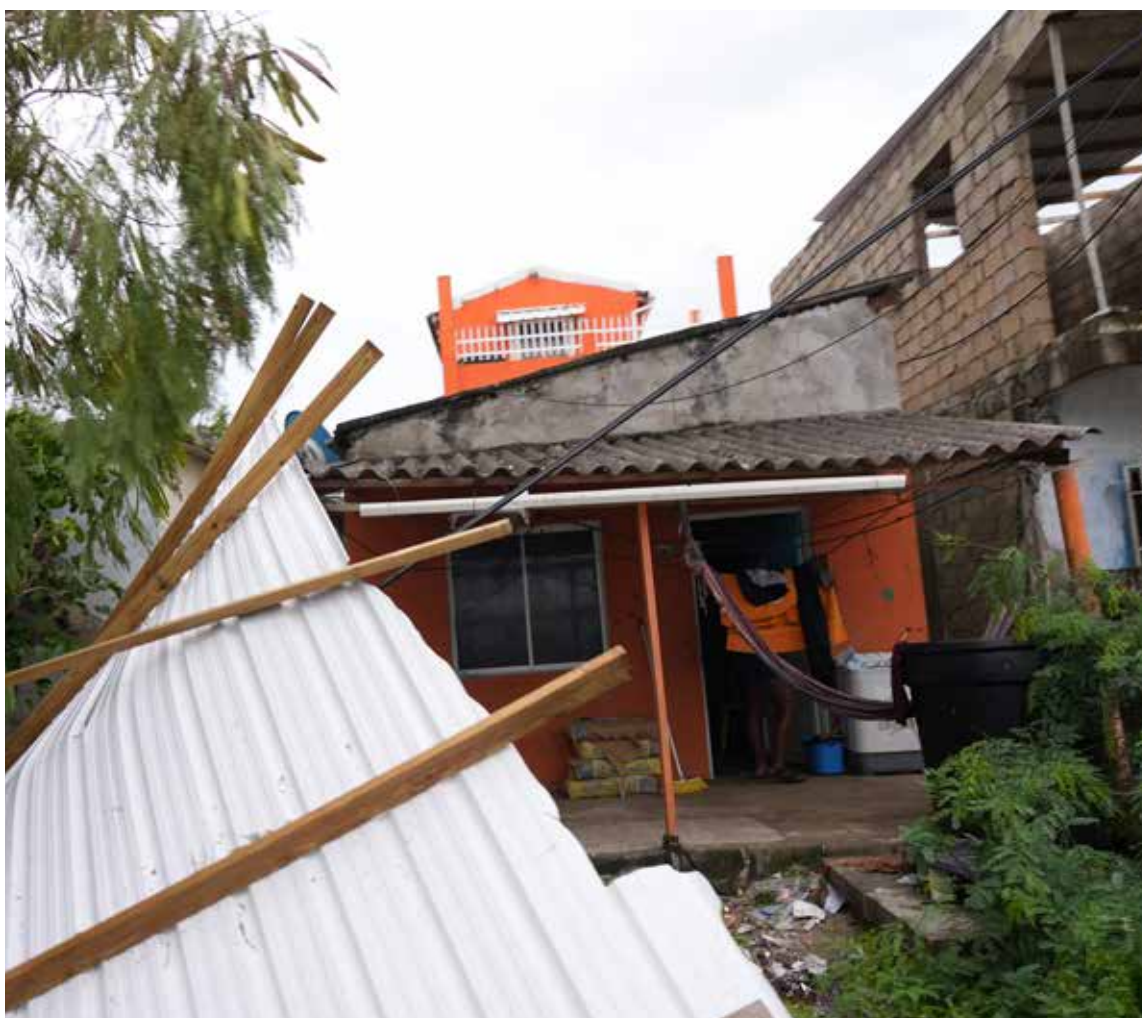
Daños registrados en viviendas de San Andrés, al paso de la tormenta Julia.
