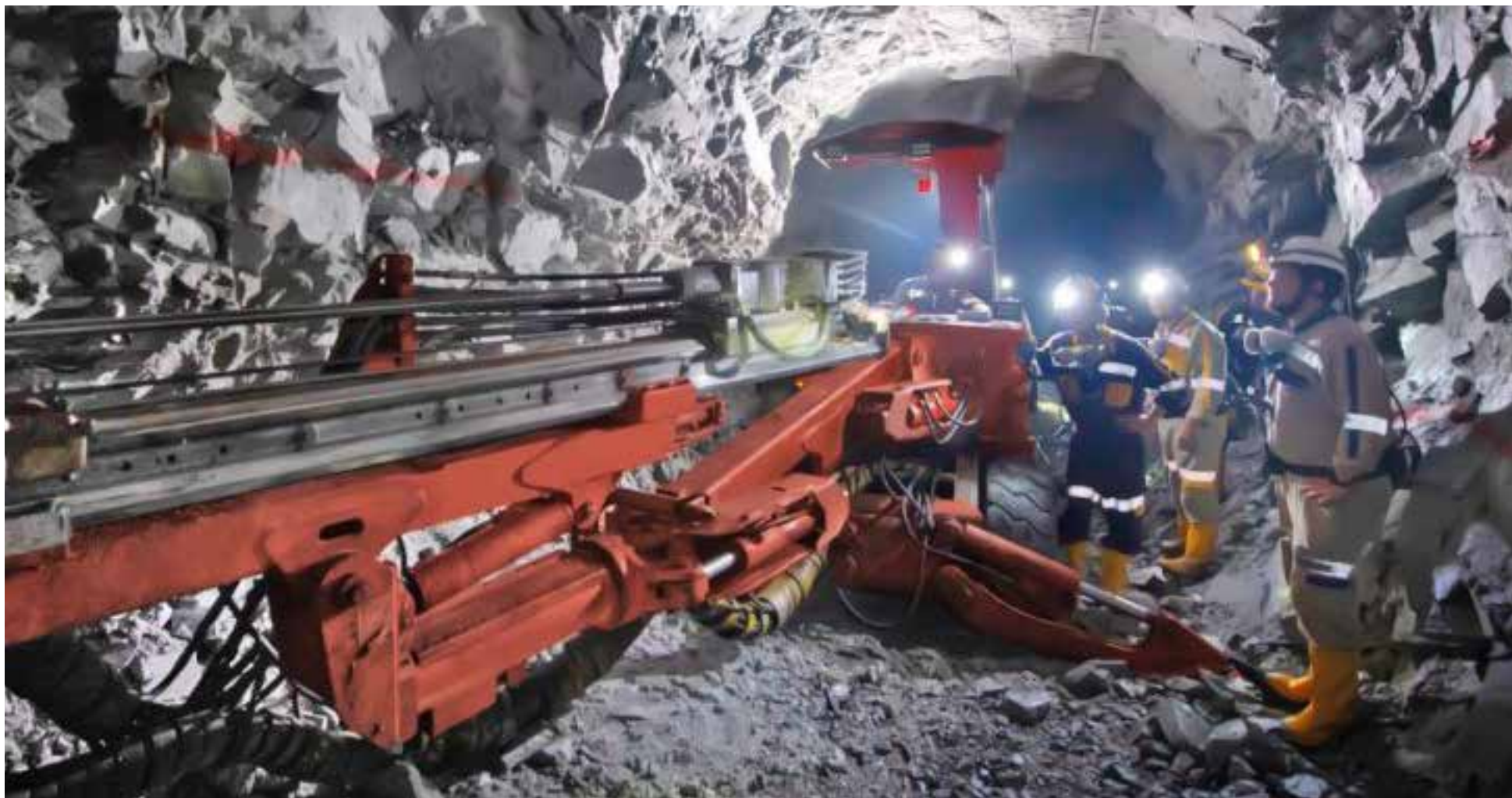
Interior de la mina.
