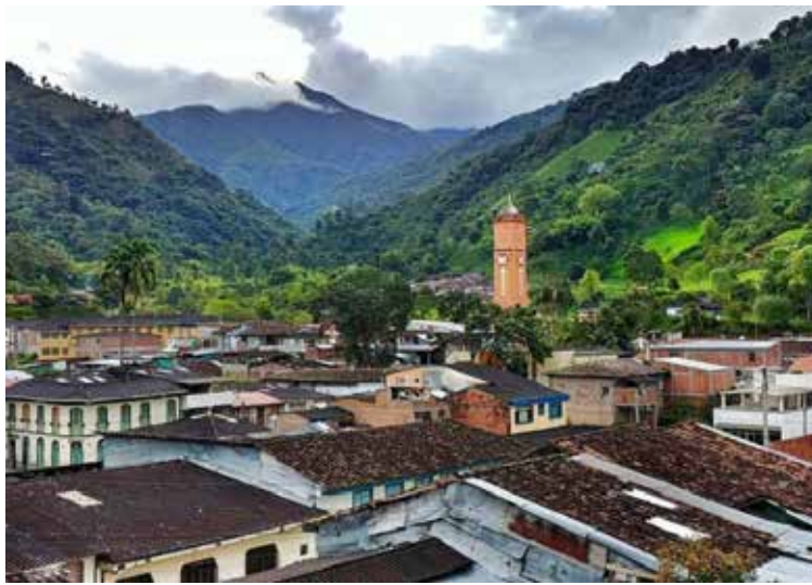
El pueblo fue construido en la zona inundable del río Lejos.
