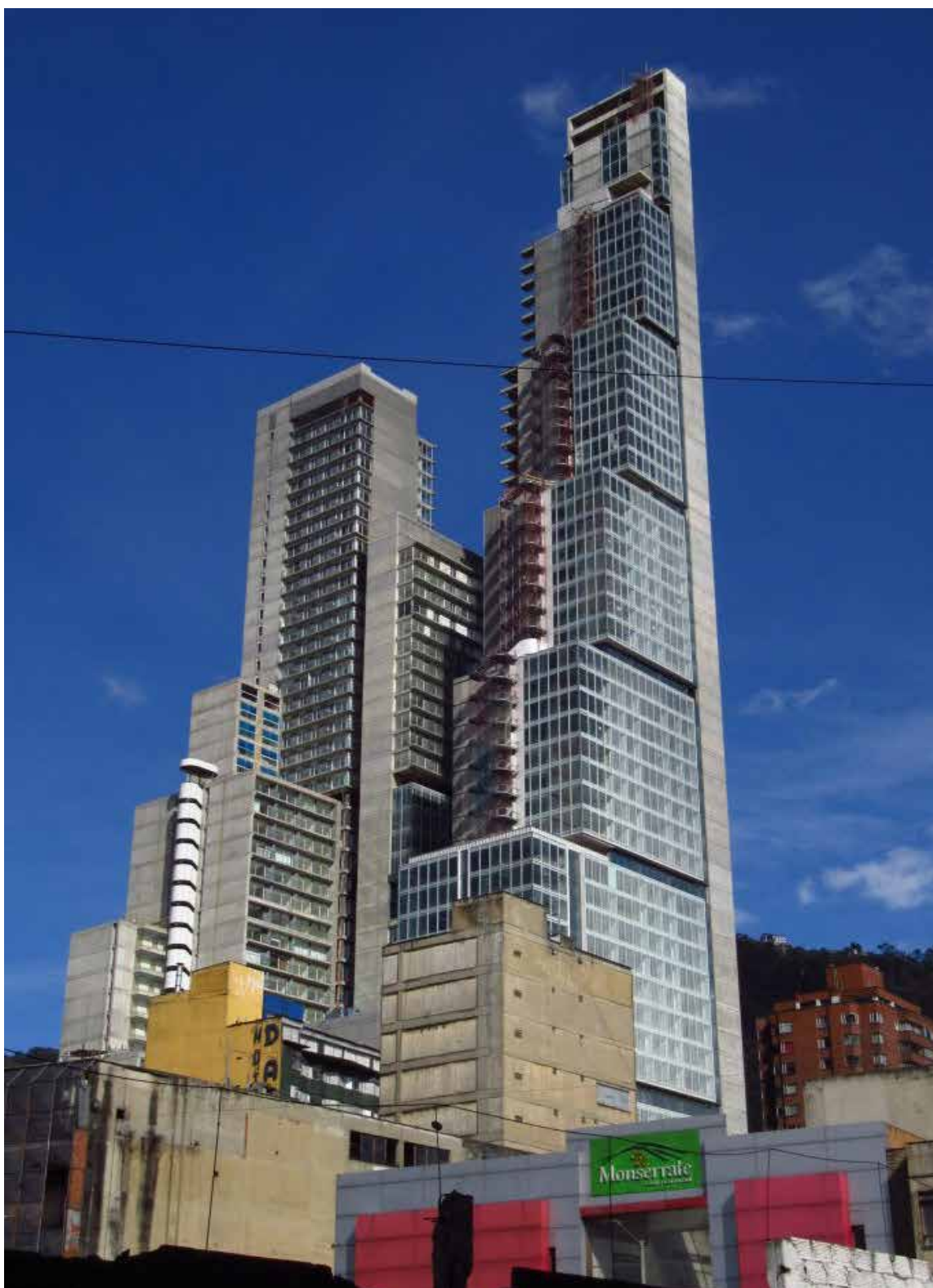
Los pisos de arriba se encuentran en obra negra. El dinero no alcanzó para la construcción de las escaleras de emergencia.
