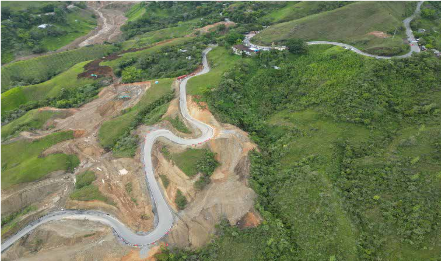
La carretera que logra reanudar el paso de vehículos de carga pesada en el municipio de Rosas Cauca.
