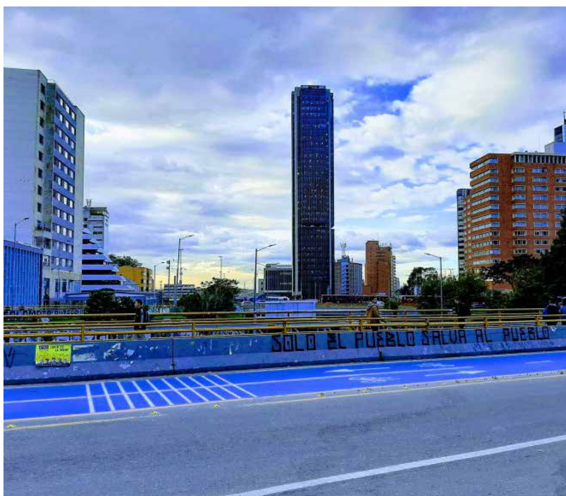
El corredor contará con 22 kilómetros de longitud, se dividirá en tres tramos y tendrá un valor final de 2,5 billones de pesos.
