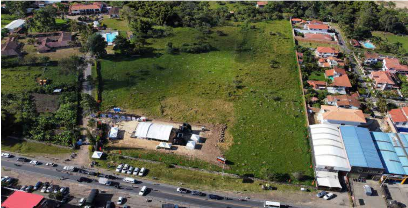
El lote donde se levantará el nuevo hospital regional San Rafael de Fusagasugá
