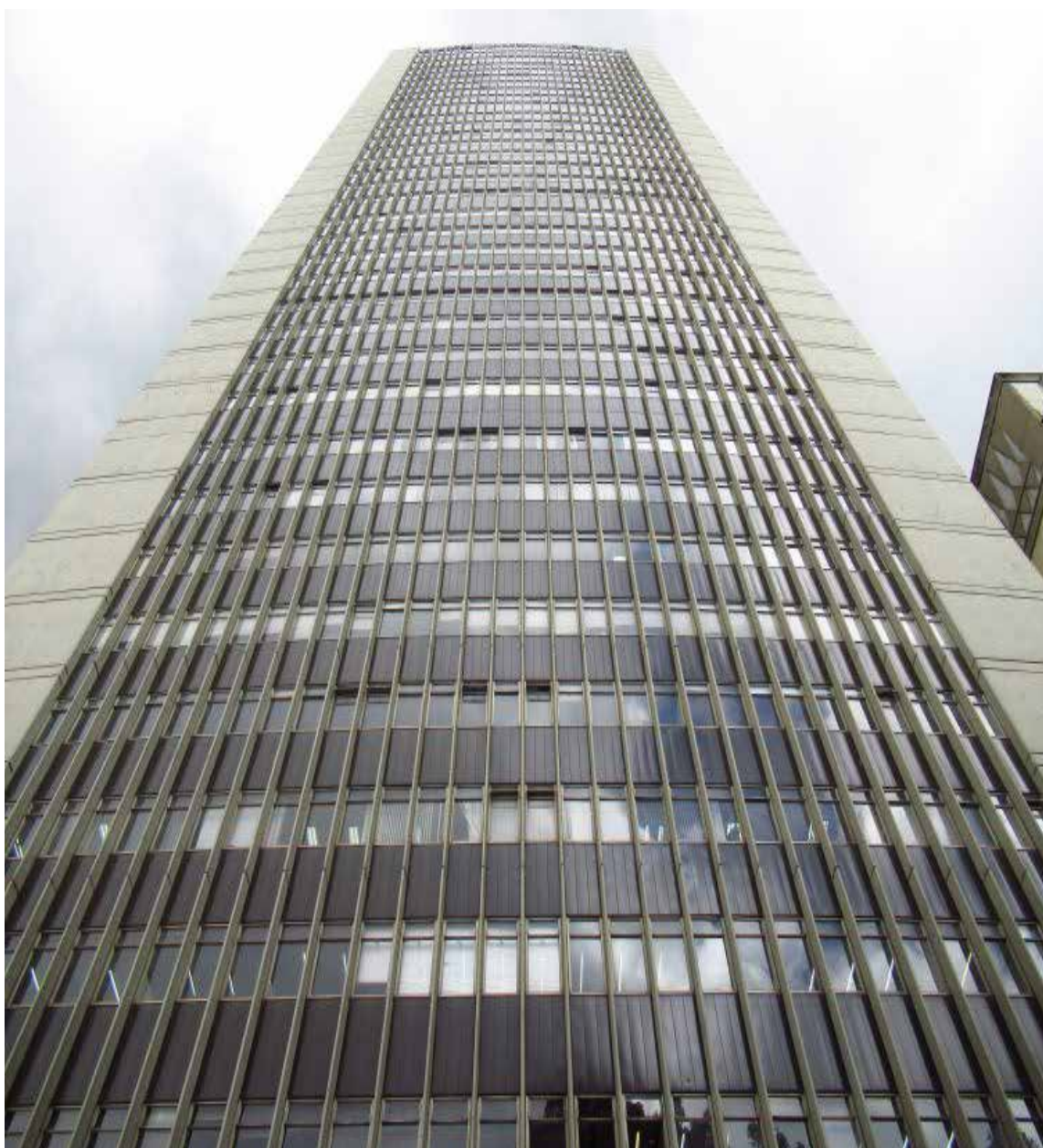
Edificio de Avianca en la actualidad.
