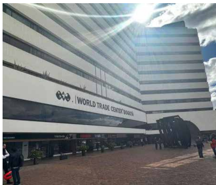
En el edificio World Trade Center Bogotá, las dilataciones entre las torres B y C que se están mostrando por redes sociales son unas dilataciones que están desde el inicio de la construcción hace cerca de 40 años, dijeron los responsables de la edificación
