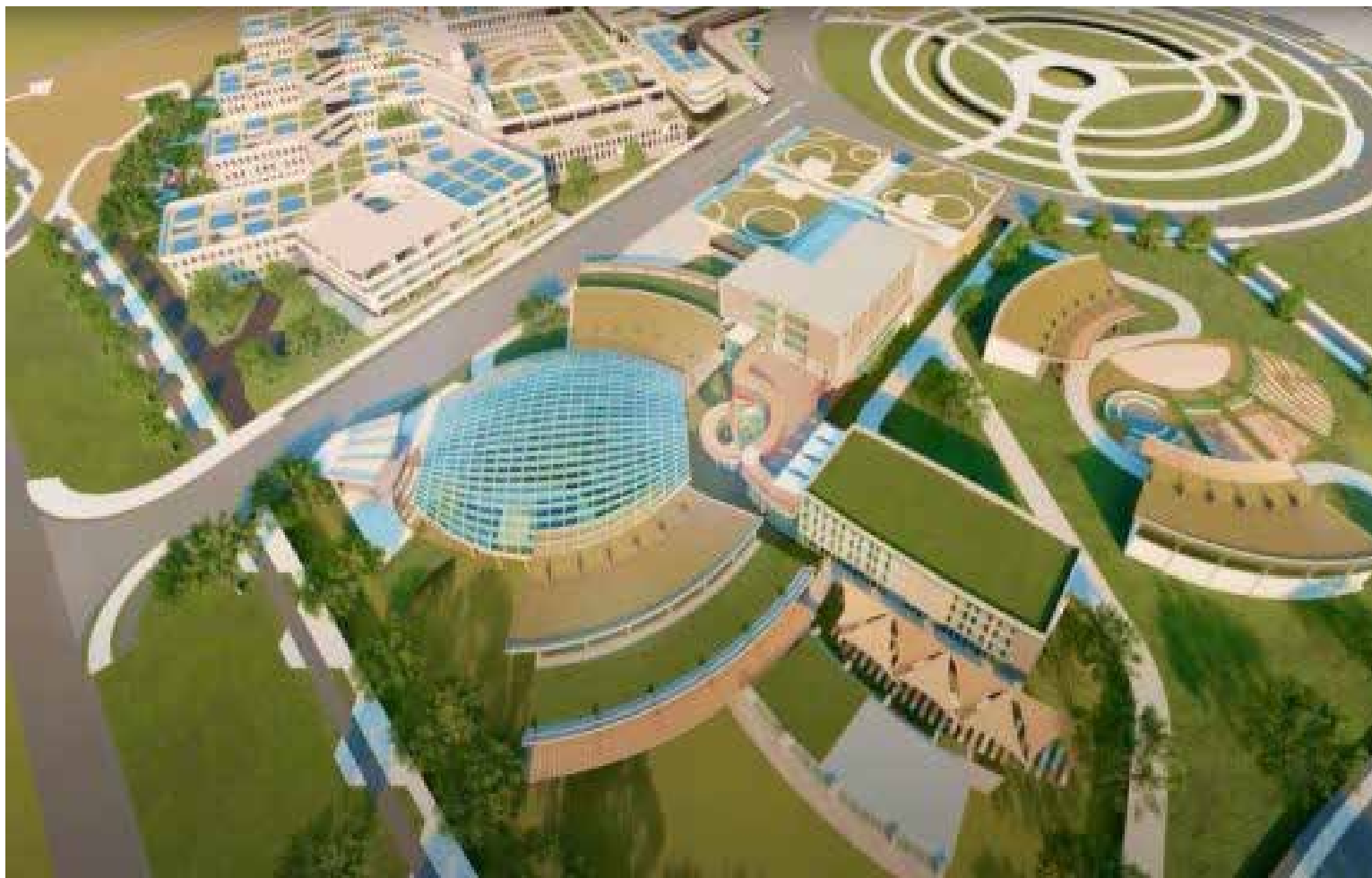
El campus de la Universidad La Gran Colombia en Cumaral en construcción, donde se beneficiarán 10 mil estudiantes del Piedemonte Ilanero.
