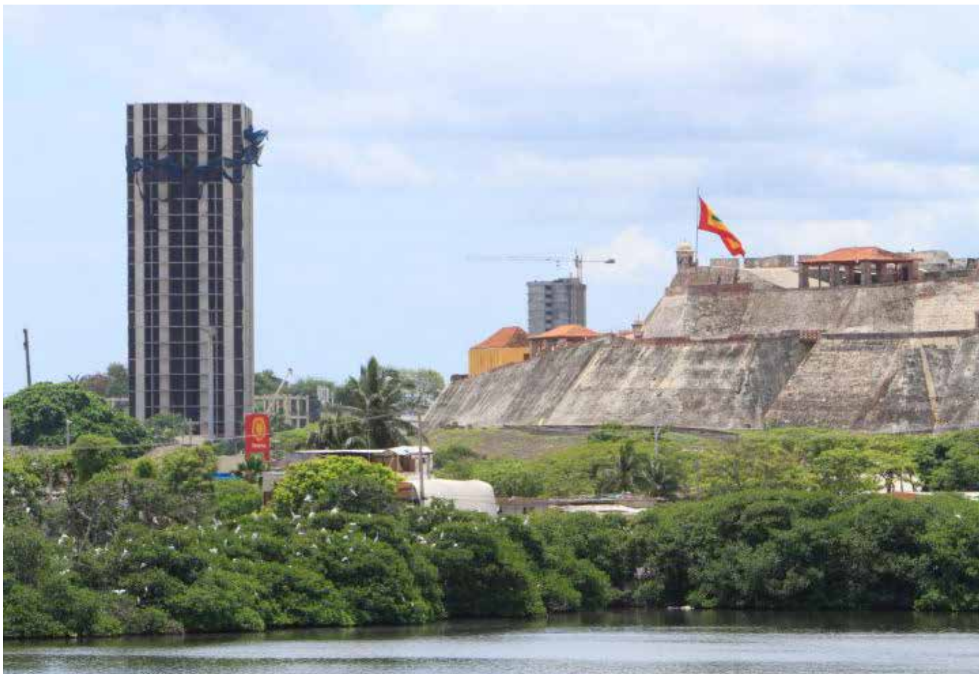
Edificio Acuarela, que será demolido en las próximas semanas.
