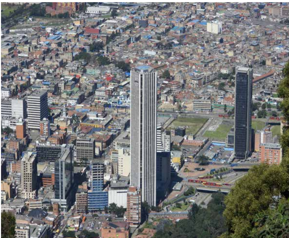
Sobresale el edificio de Colpatria
